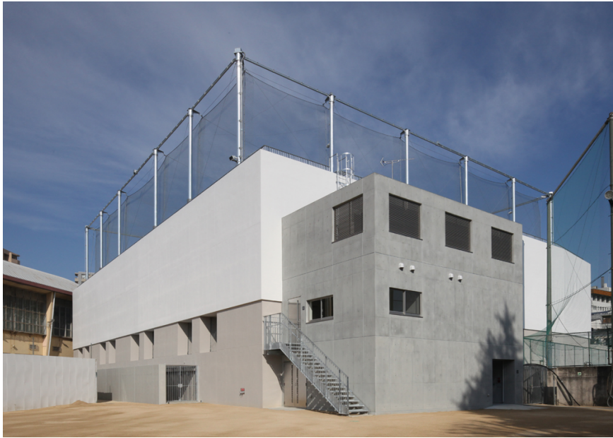
東 グラウンド砂場側 手前は体育科教員室
