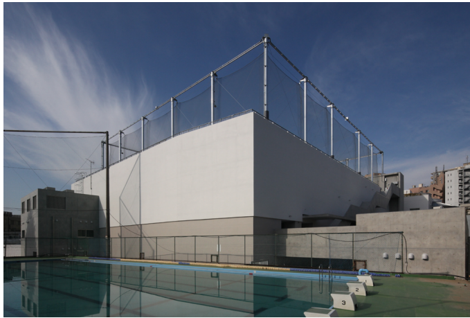
北東 プール側
